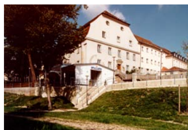
Private Schutzmaßnahme beim Spitalgarten
