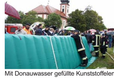
Mit Donauwasser gefüllte Kunststoffelemente
