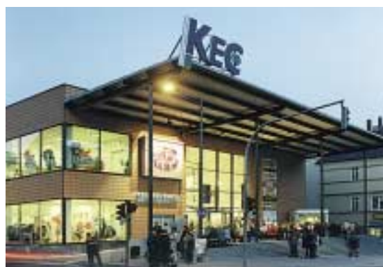
Der Fußgängersteg verbindet KEC und Altstadt. (Bild links)
