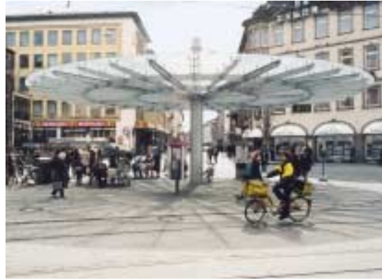
Neugestaltung der „Marktpassage“ – Marktstände und Kunden finden Schutz unter einem Glasdach mit filigraner Stahlkonstruktion (Bild links)
