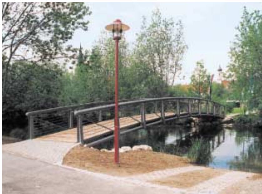
Ansprechende Konstruktion – Fußgängerbrücke über die Brenz
