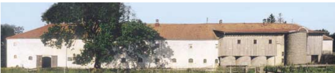
Der Fohlenhof: Im Umnutzungsprogramm sind bis jetzt Rathaus, Grundschule, Sporthalle, Pfarrgemeindezentrum und Fremdenverkehrsamt verwirklicht – die Zukunft der Westseite ist noch offen.
